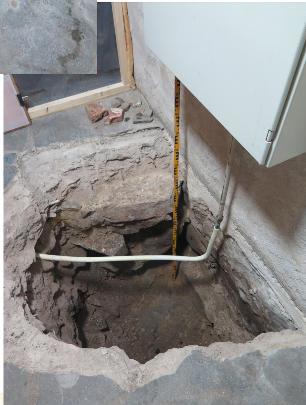
Figur 22. Översikt över det utgrävda schaktet med berggrund i botten. På bilden syns tydligt att den anslutande korsarmen har plockats bort i samband med att trapphuset grundlades.
